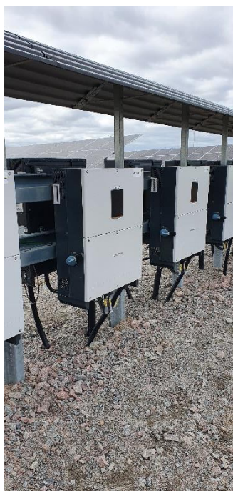
Figur 6: Växleriktare typ Sungrow 110CX tillhörande solcellspark i Fyrislund, Uppsala. Foto: Nils Norlander.
