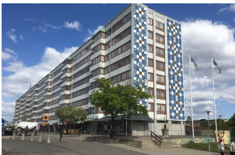
Figur 5: Solcellsanläggning på fasad, Friskvåderstorget Göteborg.
